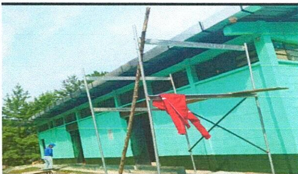
Foto 3: laminas nuevas instaladas
